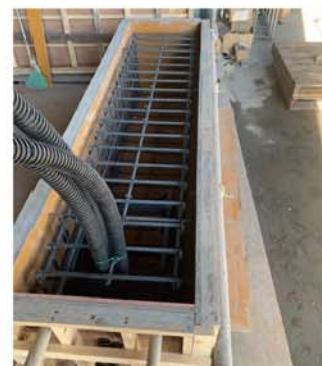
型枠の組み立て
